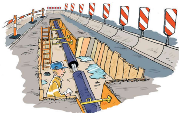
Figur 3: Udgravning med afstivning når det ikke er muligt at lave skråningsanlæg. Brug strækplanke hvis der graves dybere end 2,25 m.
